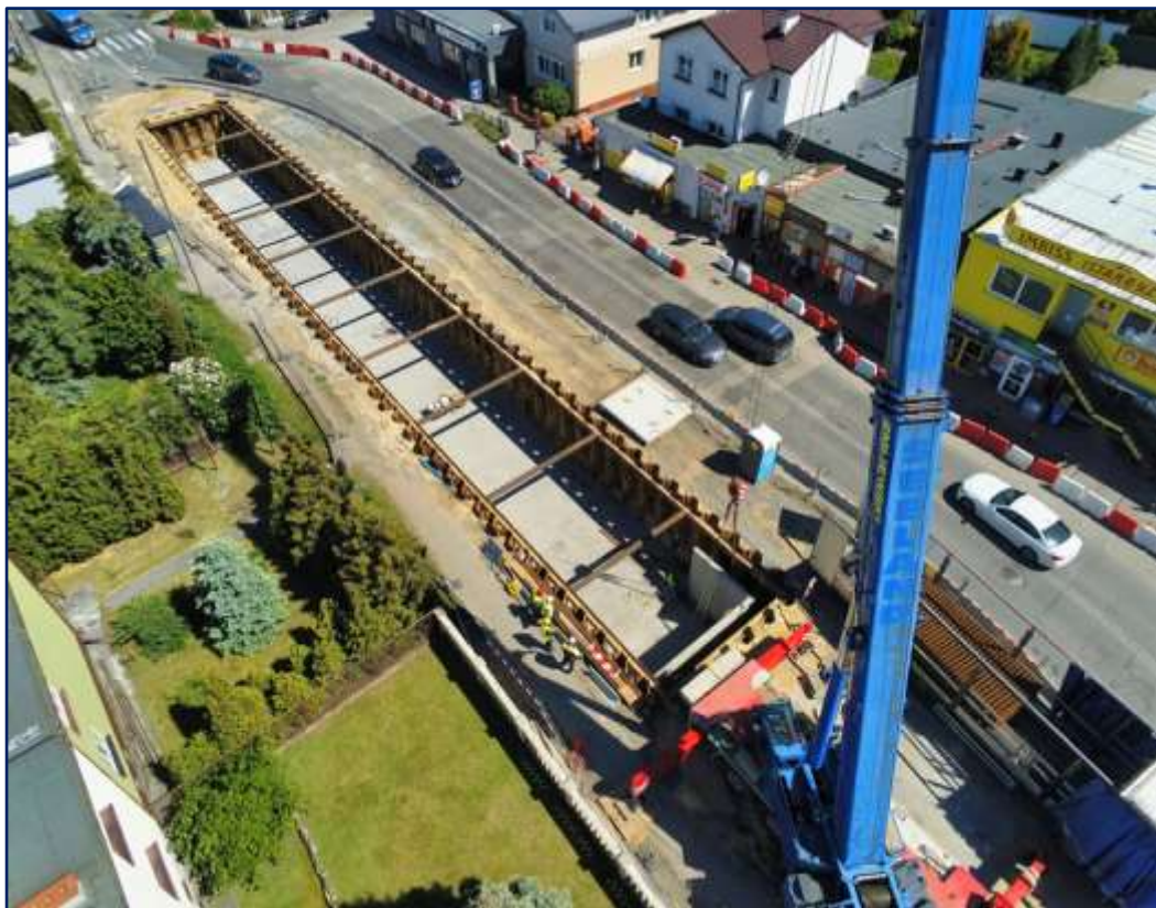
Zbiornik retencyjny w ulicy Kolbego (pojemność 545 m 3 )
