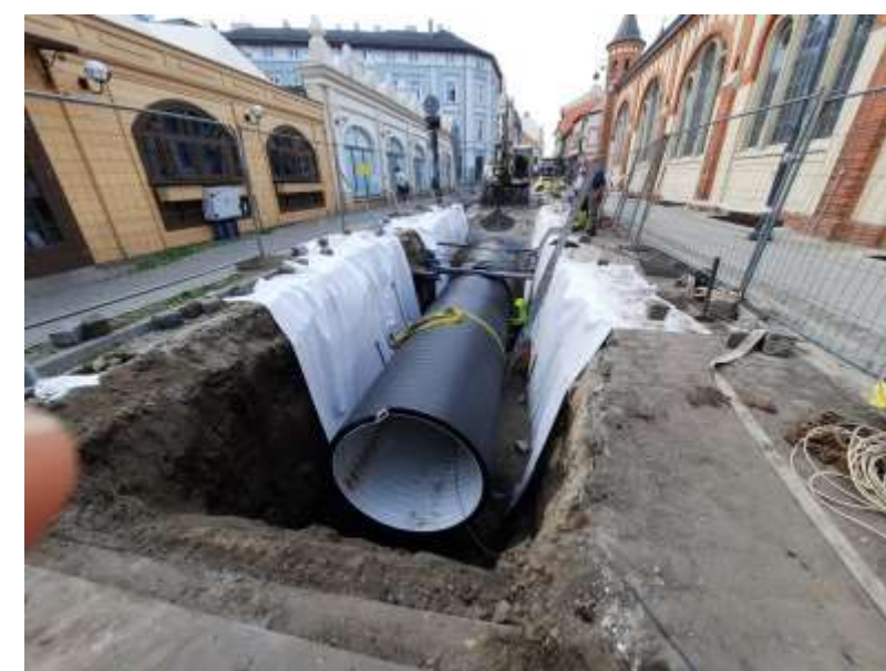
Retencja kanałowa w ulicy Magdzińskiego (materiał - PE (polietylen spawany) długość 40 m, średnica 1,8 m, pojemność 100 m 3 )
