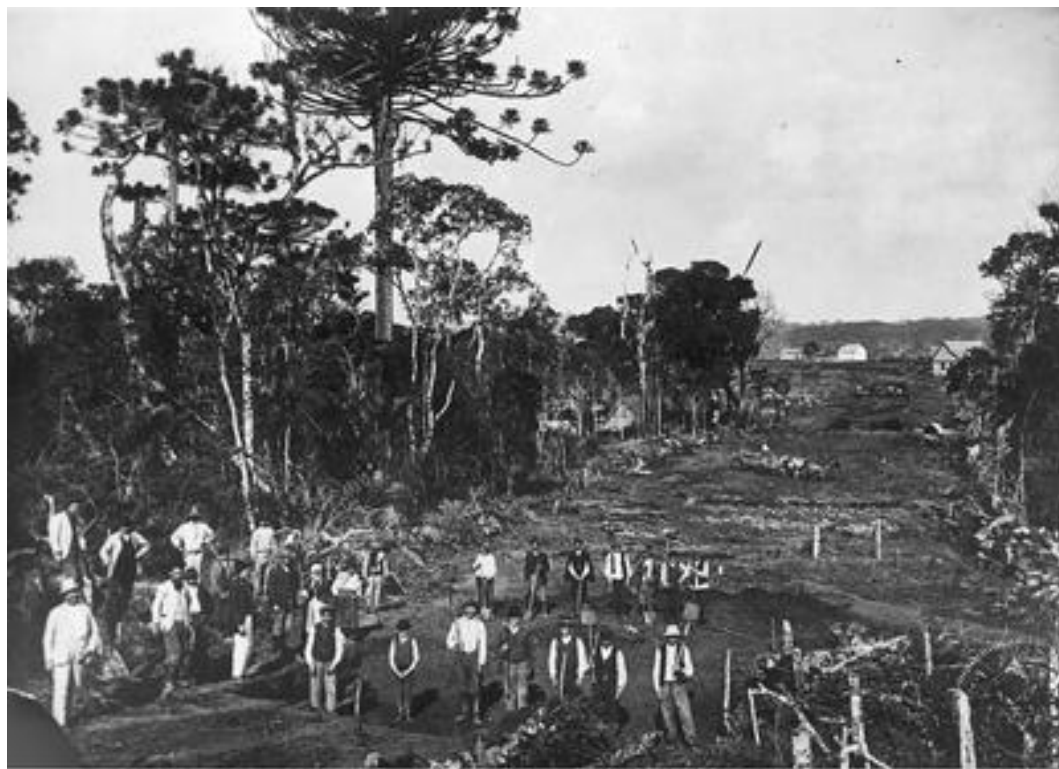
Koloniści pracujący przy budowie drogi na terenie kolonii polskiej w Cruz Machado w stanie Parana, 1928 (fot. Narodowe Archiwum Cyfrowe)
