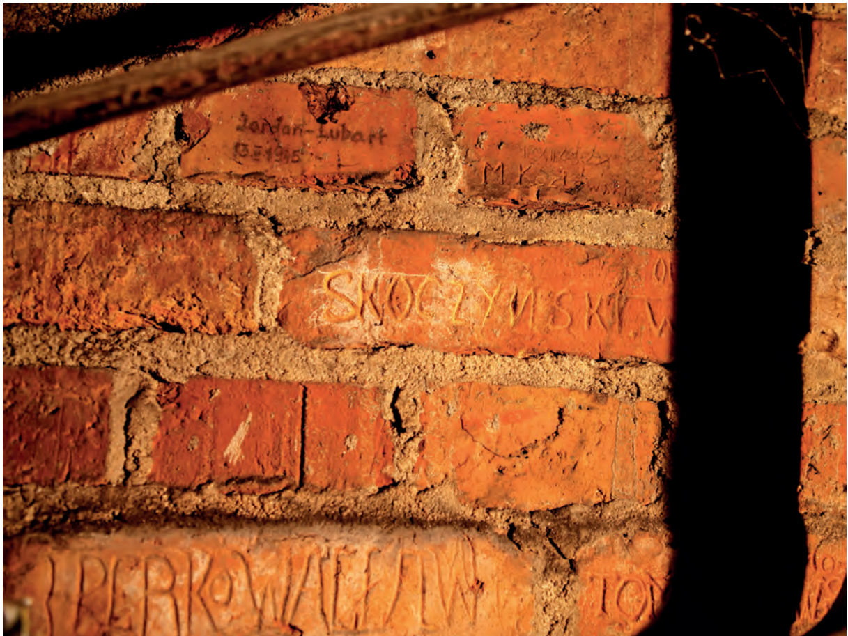
Piwnice byłej katowni NKWD/UB na warszawskiej Pradze, ul. Strzelecka 8, zakupione przez IPN. Fot. Marcin Jurkiewicz/IPN
