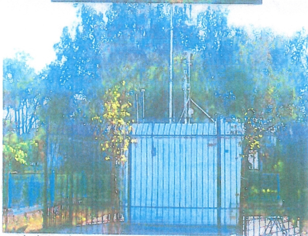
Stacja monitoringu zanieczyszczenia powietrza w Kędzierzynie-Koźlu, ul. Bolesława Śmiałego 5 (OpKkoze1a)
